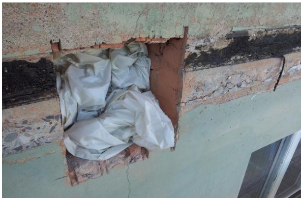
Foto: fasade bakgård etter hulltaking for balkonginnfesting
