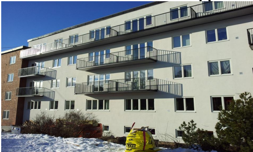
Foto: etterisolert fasade mot bakgård med nye balkonger
